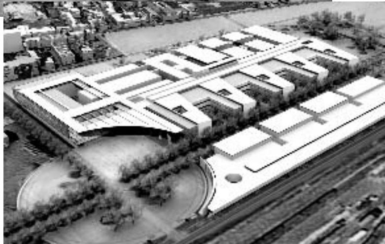
Sur le site d'Estaing, 70 000 m 2 sur 3 niveaux seront en service en 2008.
